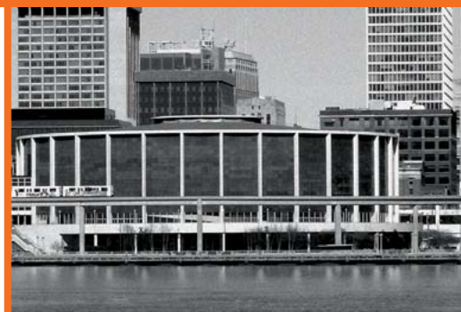
Cobo Hall Arena, Detroit, MI.
